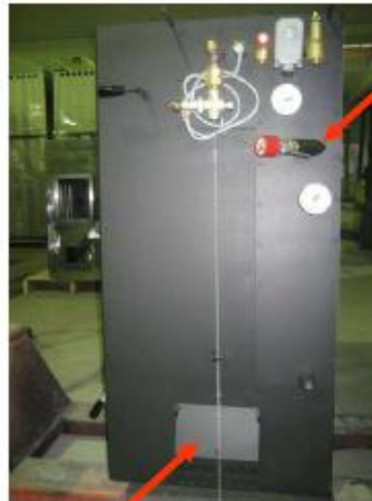
a) Feuerungsregler (schließt Verbrennungszuluft komplett bei 90°C)
